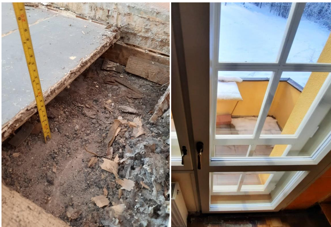
Obr. 1: Skladba podlahy ve 2NP umožňuje zateplení deskami z minerálních vláken o tl. 70 mm, při zachování stávající výšky podlahy, která nenaruší otevírání balkónových dveří.
